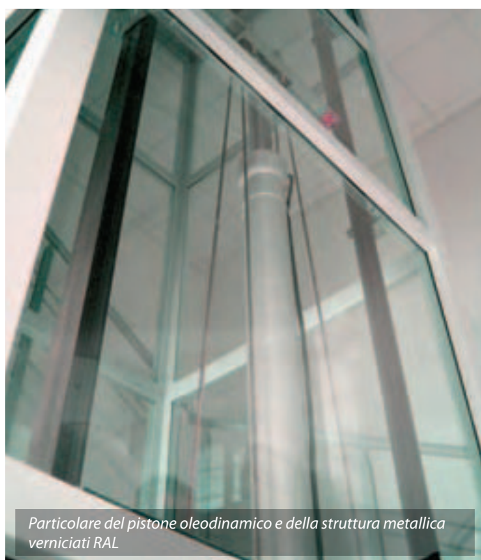
Elfo con vano in acciaio BA, tamponature in vetro "Bronzo" e porte di piano panoramiche rivestite in inox BA
